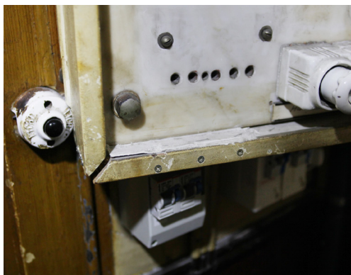
Abb. 6/7: Asbestverkleidung in einer veralteten Elektroverteilung
