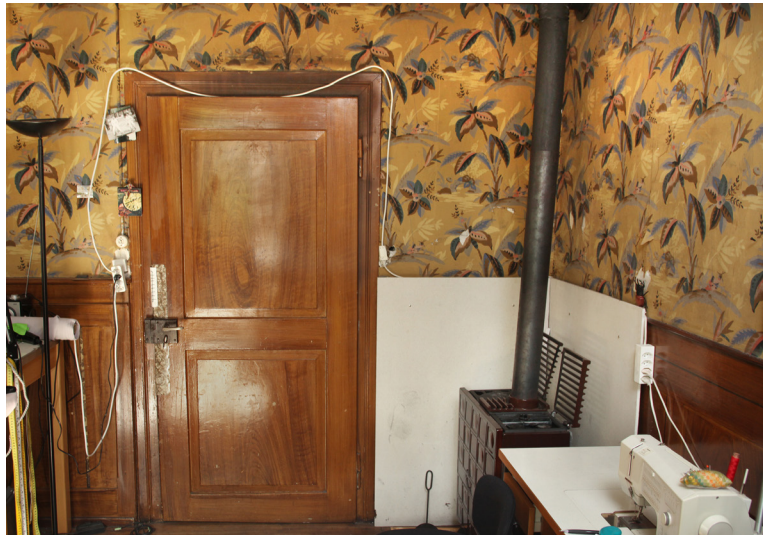
Abb. 3: Gefährliche Laieninstallation
