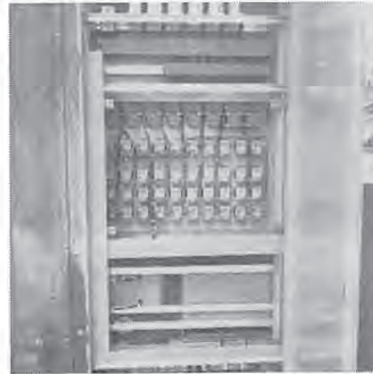
Rückseite heute (oben Kondensatoren für Kompensation)
