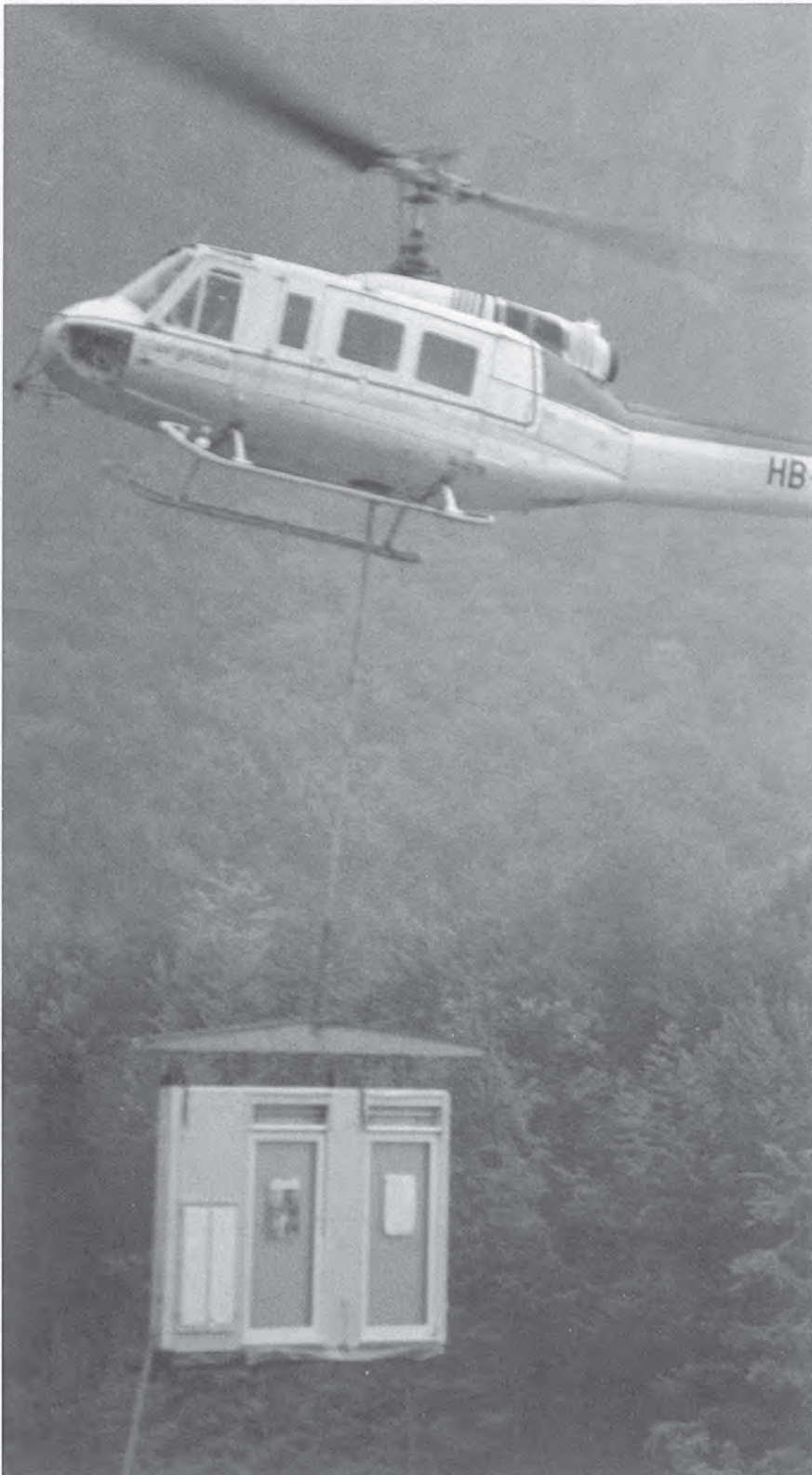
Der Heli im Anflug mit einer Aussenwand.
