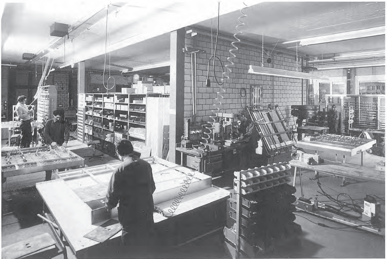
Übersicht über unsere Werkstatt: Montage von Zählereien und Sicherungsverteilungen.
