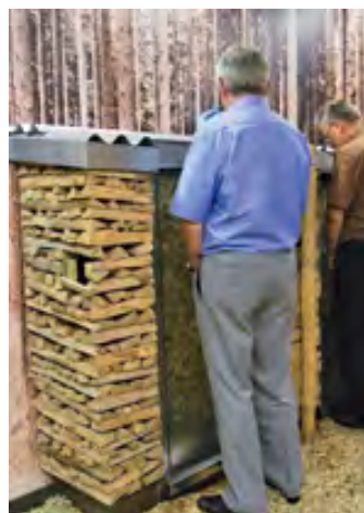
Bis ins Detail ist alles, auch das Pissoir, originell und original.
