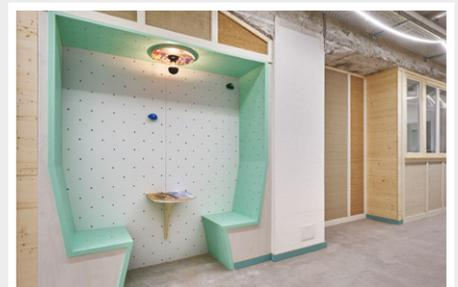
Aus der vorhandenen Kletterwand und Reklametafeln von Transa wurde eine gemütliche Besprechungsnische im Gang. Die Nische wurde mit geschichteten Spannplatten aus den ehemaligen Einbaumöbeln sowie abgehängten Akustikdecken eingefasst. Die Fussleiste stammt aus einem Rückbau in Baden und kleidete vorher die Fassade eines Schulhauspavillons. Weiter konnten aus diesem Pavillon Bauholz, Wandtafeln und Leuchten für das Projekt an der Josefstrasse gerettet werden.
