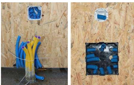
Die im Beton eingelegten Rohre sind nahe an der Wand. Da werden enge Bögen kaum zu vermeiden sein. In der Abzweigdose wirds dann sowieso recht eng.
