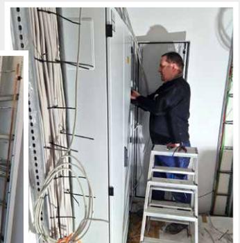
Bauleiter Steffen Philipp kümmert sich derweil um die Montage und den Anschluss der Unterverteilung im 2. Obergeschoss.
