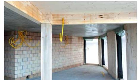
Holz trifft auf die anderen Baustoffe. Fassade, Decke und Stützen aus Holz, Innenwand aus Backstein, Boden aus Beton.
