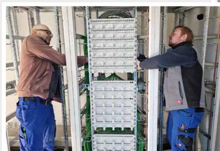
2023: Neubau Glaserei Vodafone im Messegelände. Auftragswert EUR 700'000. Monteur Rico Busse und sein Kollege Tobias Müller schliessen die insgesamt 385 Datenmodule an.
