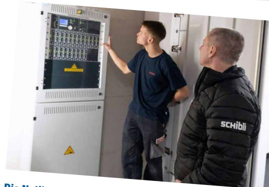
Die Notlichtanlage. Eine der umfangreichen Betriebs- und Sicherheitsanlagen installiert von Schibli. Neben dieser haben wir ein Zutrittskontrollsystem, eine Audioanlage sowie eine Brandmeldeanlage umgesetzt.
