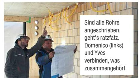
«Lärmige und staubige Spitz-, Fräs- und Gipsarbeiten fallen mehrheitlich weg, was uns natürlich effizienter macht. Die Vorgefertigung der Elektroinstallationen in den Holzwänden ist schon noch ungewohnt. Auf den ersten Blick sehen wir viele Rohrenden in den Kästchen. Es wird in manchen Steckdosen, Schaltern und Abzweigdosen doch sehr eng», erzählt Domenico und lacht.
